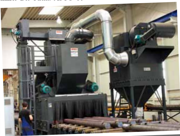
Die moderne Durchlaufsandstrahlanlage in der neuen Produktionshalle
